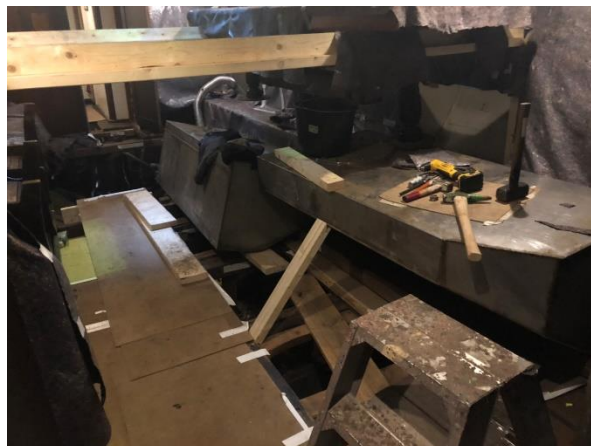
Demontage der Frischwassertanks im Salon
