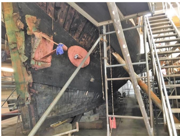
eingerüsteter Rumpf, demontierte Plankengänge
