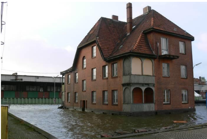
Hochwasser im Dezember 2013 bei der Stiftung Hamburg Maritim.
