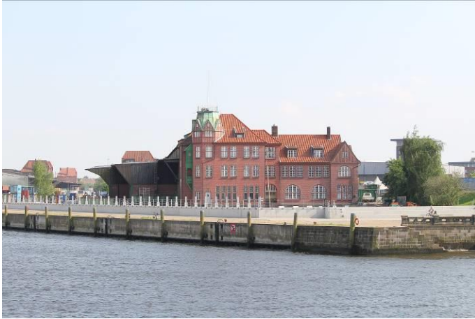
Das Hansahöft mit dem neuen Hochwasserschutz von der Wasserseite aus gesehen.
